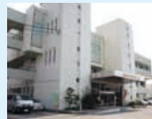
〈JA大阪南〉平成10（1998）年4月1日に、南河内地区5市3町1村の9JA（大阪河南町、太子、羽曳野市、美原町、千早赤阪、大阪狭山、藤井寺市、河内長野市、富田林市）が合併して発足。「農と緑を守り、地域社会の発展に寄与するため、役職員自ら意識改革により、リーダーシップを発揮します。」を経営理念とする。
